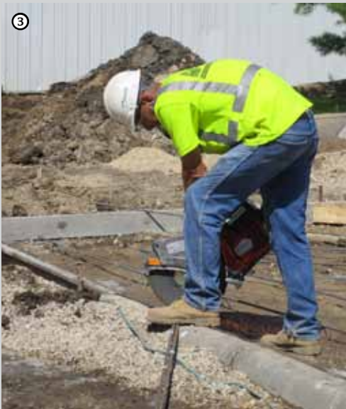
1. Cory Gilman, Troy Jacobson and Dennis McKee at a concrete pour at Cabelas in Prairie du Chien. 3. Dennis McKee cutting rebar at Cabelas. 5. Concrete pour at Cabelas in Prairie du Chien.
